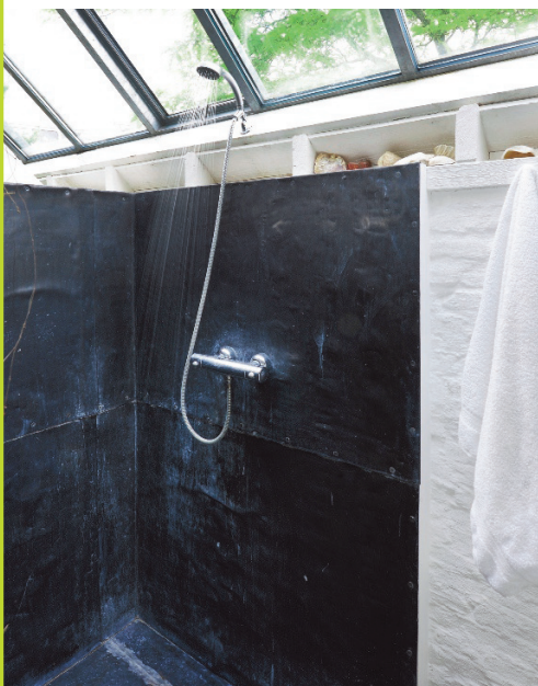
Onder de douche, waarvan de wanden bekleed zijn met lood, lijkt het alsof je buiten staat.
